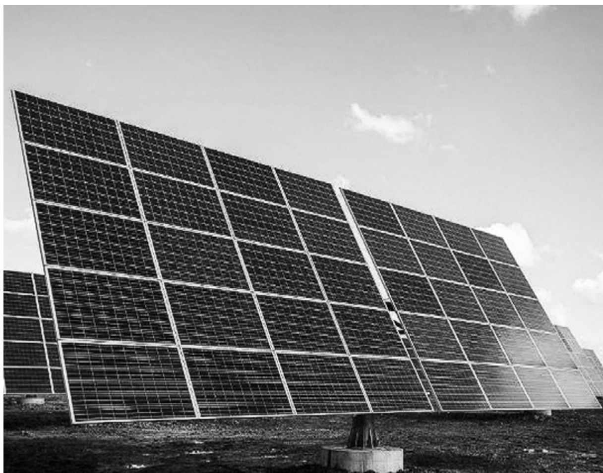
Поворотные модули производят на 50% больше энергии, чем стационарные
