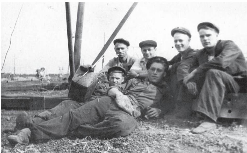
На фото: Бригада монтажников, которые ставили копер. В центре (лежит) – Василий Иванович Жанталай, который потом работал в ШСУ-6 бригадиром монтажников
